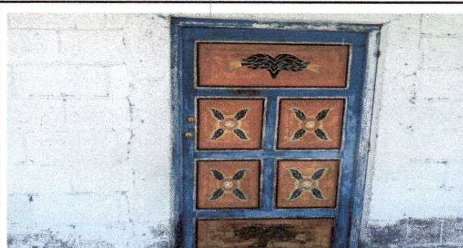
Foto 4: Sustrucción de puerta de madera a metal
